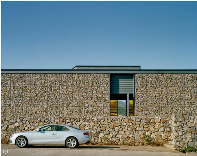
Muito utilizados em obras de infraestrutura, os muros de gabião são constituídos por gaiolas metálicas conformadas por malhas hexagonais de fios de aço galvanizados, de modo que resistam às intempéries por um extenso período de tempo, livres de oxidação. Internamente são preenchidos por pedras de diferentes tamanhos, tornando-se uma estrutura permeável.
