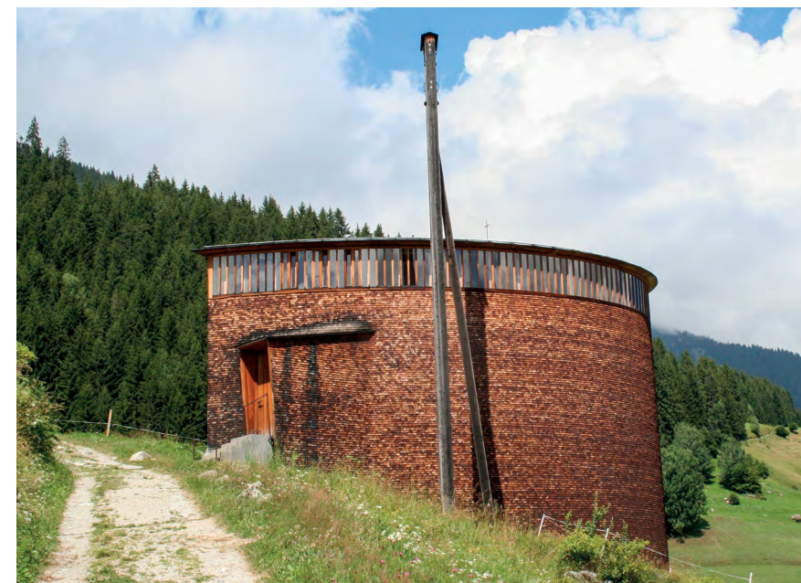
Il. 3. Sumvig, kaplica pw. św. Benedykta, proj. P. Zumthor. Fot. Adrian Michael (źródło: Wikimedia Commons, licencja CC-BY-SA-3.0)
