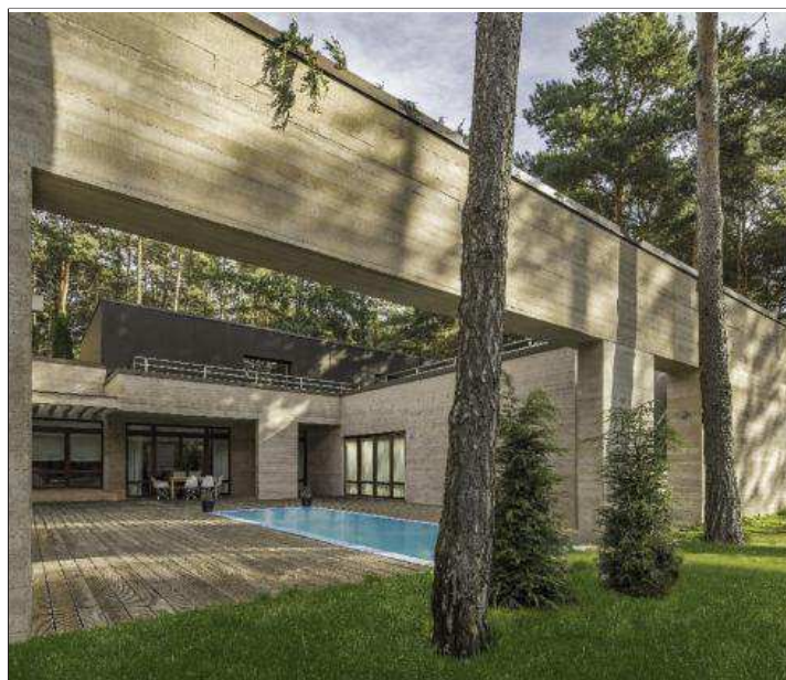
Rezydencja z betonu licowego
