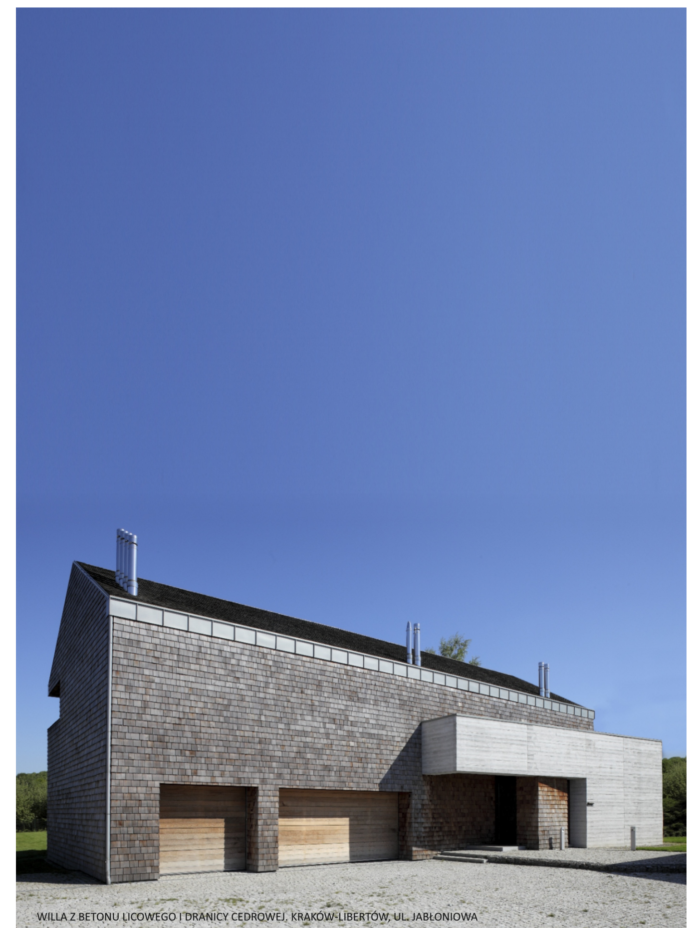
WILLA Z BETONU LICOWEGO I DRZWIAMI CEDROWYMI, KRAKÓW/LIBERTÓW, UL. JARLONIOWA
