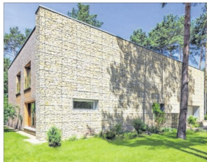
Kosze gabionowe wypełniono kamieniem dolomitowym z Libiąża
