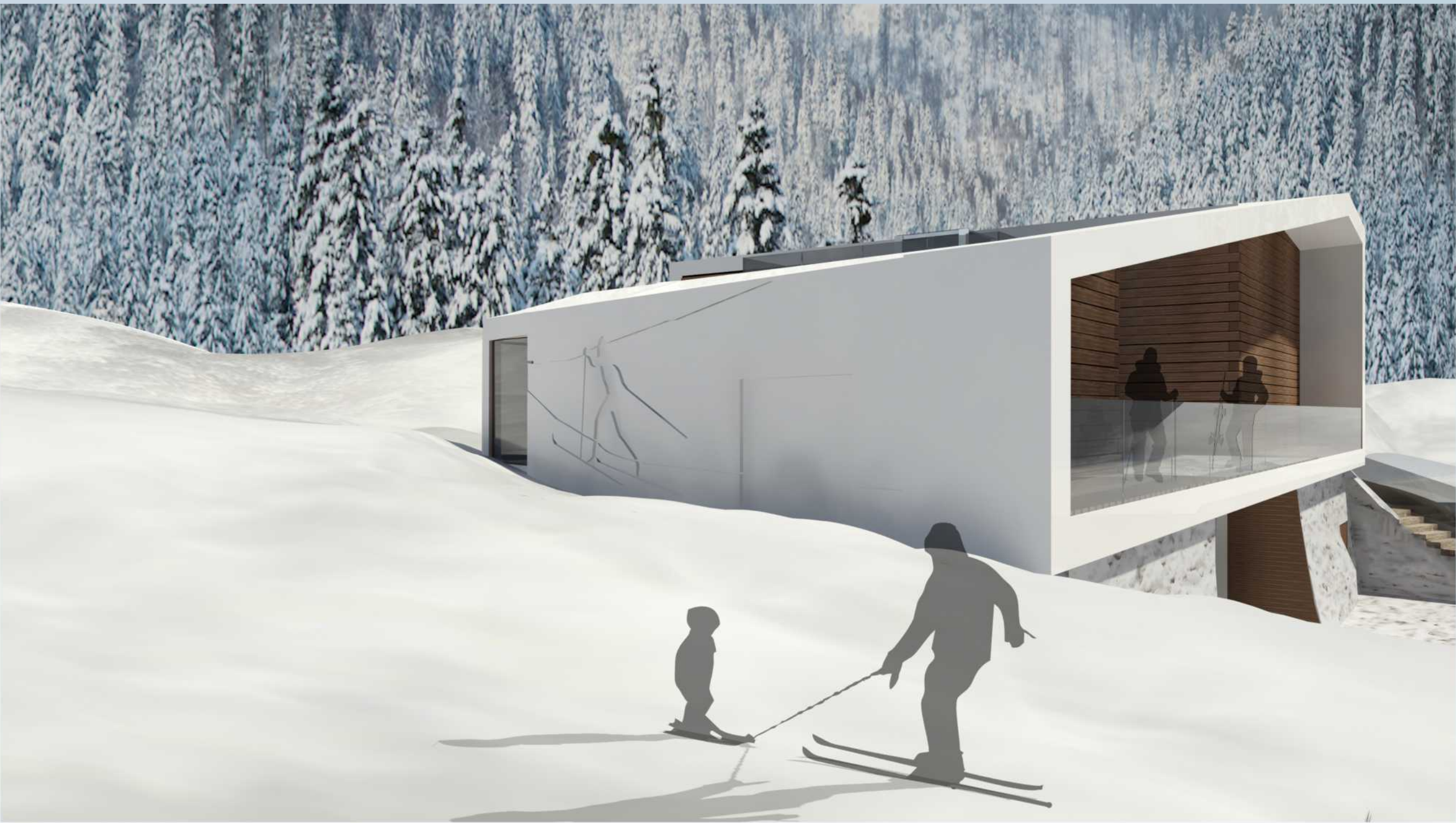
WIDOK ELEWACJI WSCHODNIEJ
