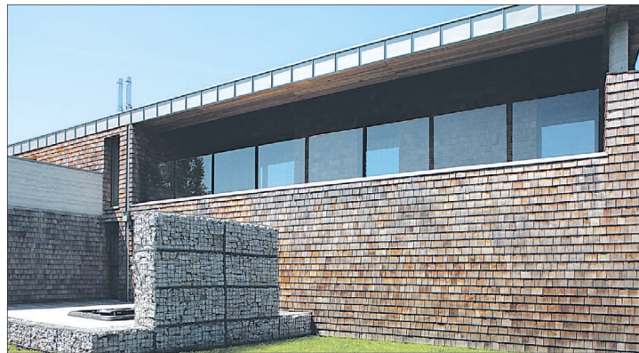
Gabiony (tłuczony kamień w stalowych koszach), zapożyczone z budownictwa hydrotechnicznego, są posadzone na tarasie ziemnym.
