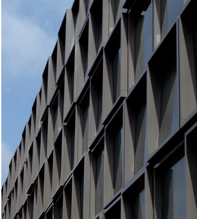
Fot. 5. Citizen M w Amsterdamie. Parametryczna elewacja budynku Fot. 6. Citizen M. Amsterdam, Prinses Irenestraat 30. Pokój hotelowy z tubusami
