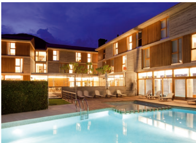
Fot. 3. Tierra de Biescas. Plastyka elewacyjna
