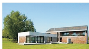
Willi z betonu licowego i dranczy cedrowej
